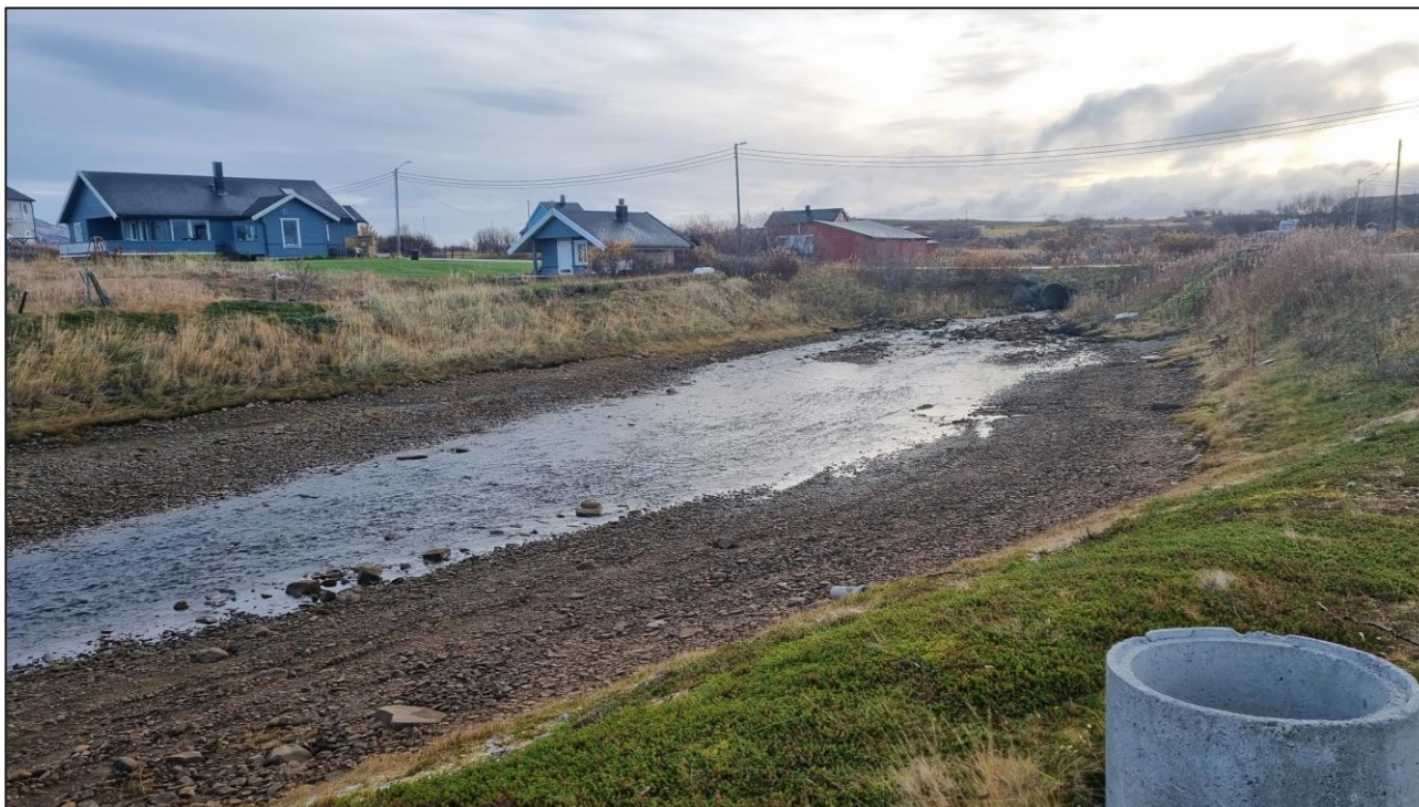
Figur 6-14 Utløpet til Røvarelvva i oktober 2025. Det vises spor av litt erosjon, uten overflateutglidninger. Foto mottatt fra Vadsø kommune.
